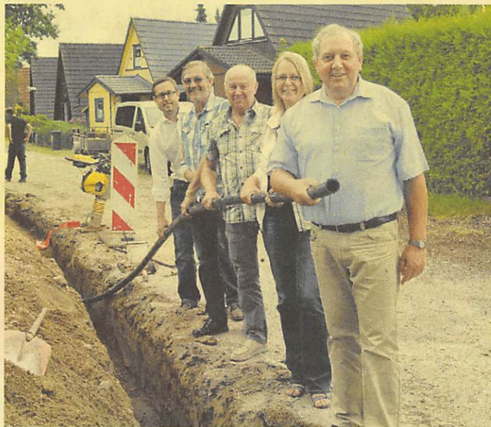
Von vorne nach hinten: Dr. Eberhard Laubach, Bürgermeister Gudow, Carina Bresch, Geschäftsführerin S.E.T., Wolfgang Babel, Fachbereichsleiter Passives LWL-Netz, VSG Netz, Harry Krause, Bauleiter Firma SET, Stephan Rakowski – Gewerbekunde in Kehrsen, betreibt sein Rechenzentrum (CSN-Solutions) zukünftig von Kehrsen aus.
