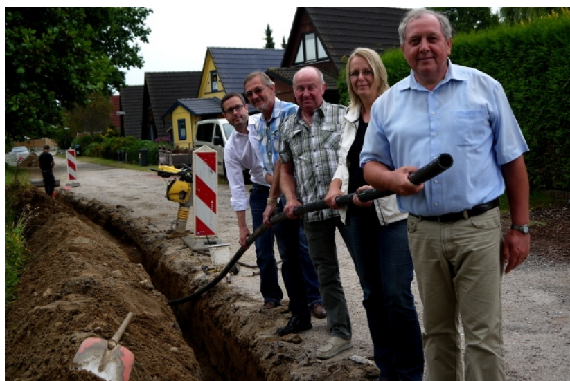
Das Leerrohr ist an vielen Stellen in Gudow schon gelegt. (v.re.) Bürgermeister Eberhard Laubach, Carina Bresch (Geschäftsführerin SET) vom ausführenden Tiefbauunternehmen, Wolfgang Babel (Fachbereichsleiter Vereinigte Stadtwerke Netz GmbH), Harry Krause, Bauleiter der Firma SET, sowie Stephan Rakowski (CSN-Solutions) zeigen, wo künftig in Gudow die Datenautobahn lang fließt. Foto: Anders
