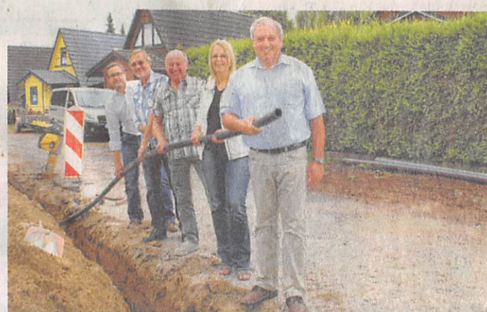
Bürgermeister Eberhard Laubach, Carina Bresch, Geschäftsführerin SET, Wolfgang Babel, Fachbereichsleiter Vereinigte Stadtwerke Netz GmbH, Harry Krause, Bauleiter der Firma SET, sowie Stephan Rakowski, CSN-Solutions, begutachten eine noch offene Baustelle, durch das Rohr sollen einmal die Glasfasern verlaufen. Foto: Ruster
