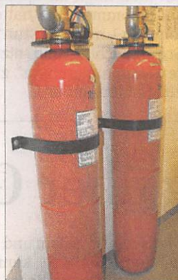
Im Brandfall hilft Gas aus diesen Flaschen, das dem Feuer den Sauerstoff entzieht.
